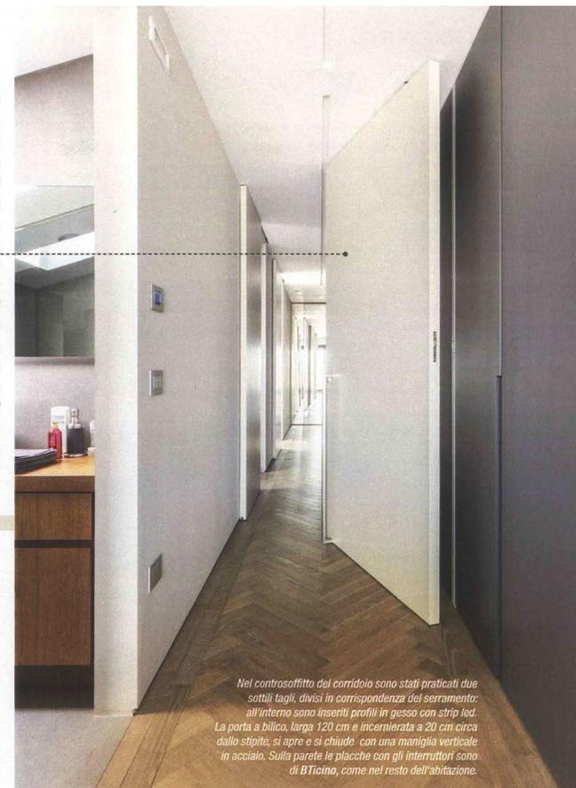
Nel controsoffitto del corridoio sono stati praticati due sottili tagli, divisi in corrispondenza del serramento: all'interno sono inseriti profili in gesso con strip led. La porta a bilico, larga 120 cm e incernierata a 20 cm circa dallo stipite, si apre e si chiude con una maniglia verticale in acciaio. Sulla parete le placche con gli interruttori sono di **B Ticino**, come nel resto dell'abitazione.
